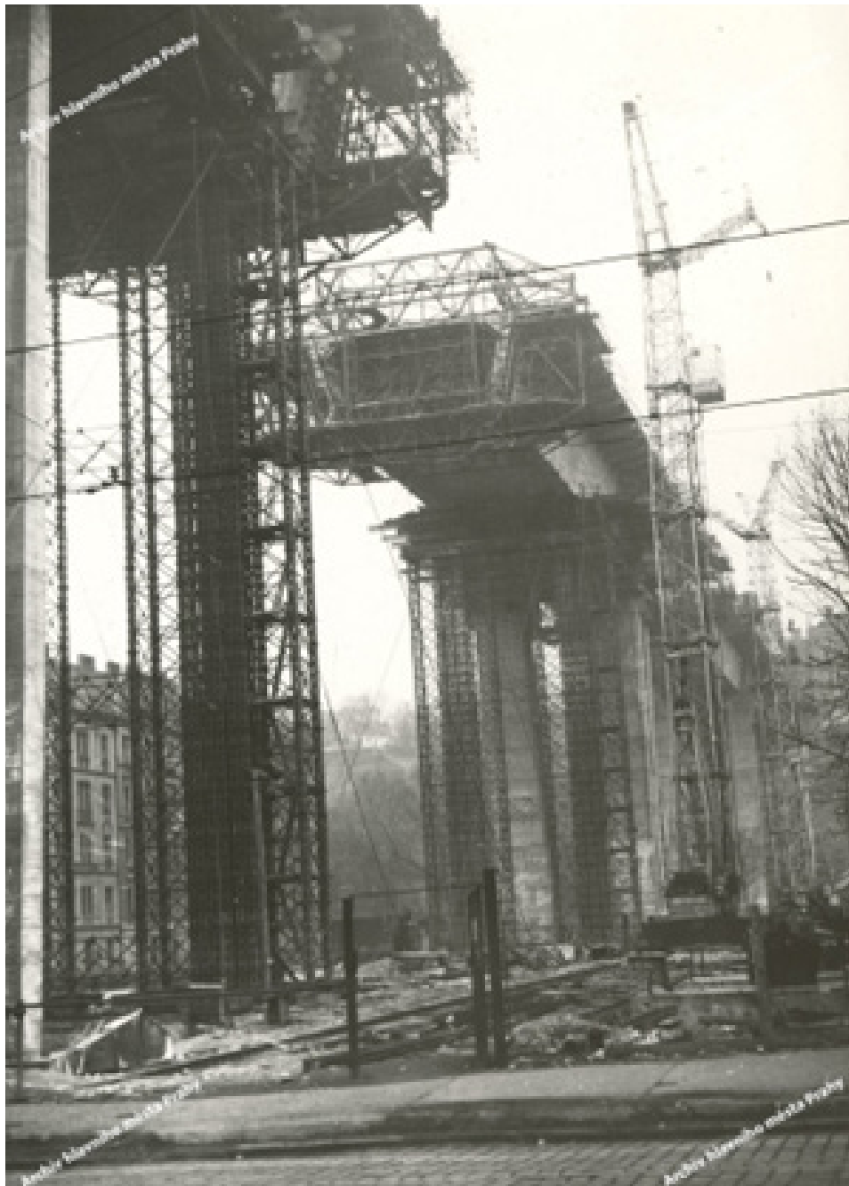
Pohled na stavbu Nuselského mostu z Jaromírovy ulice ke Karlovu. V popředí rozestavěné pilíře. Foto Josef Vopravil, 1968.
