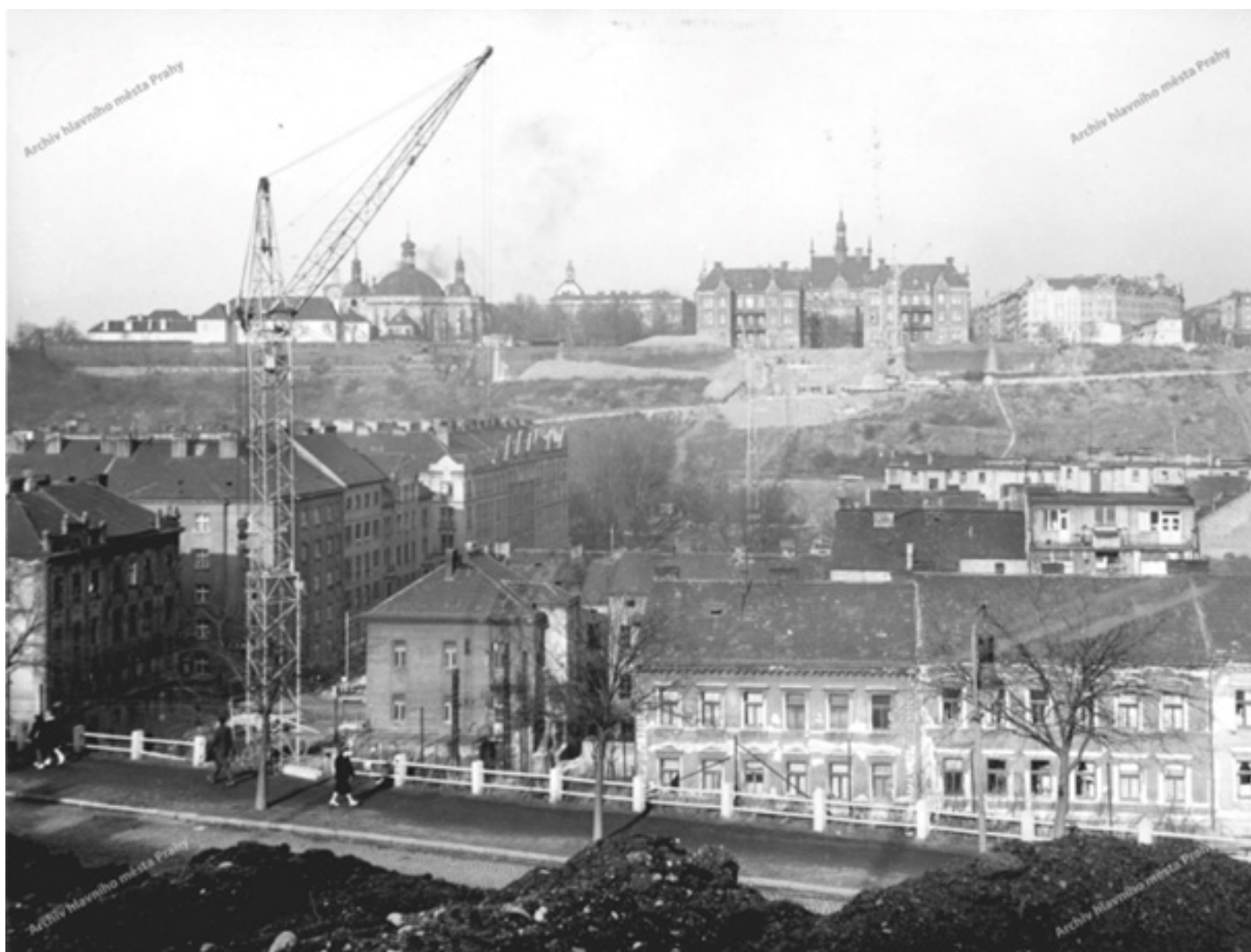
Pohled na Nuselské údolí při stavbě Nuselského mostu. V pozadí kostel Nanebevzetí P. Marie a sv. Karla Velikého na Karlově. Foto Václav Mikšátko, 1965.
