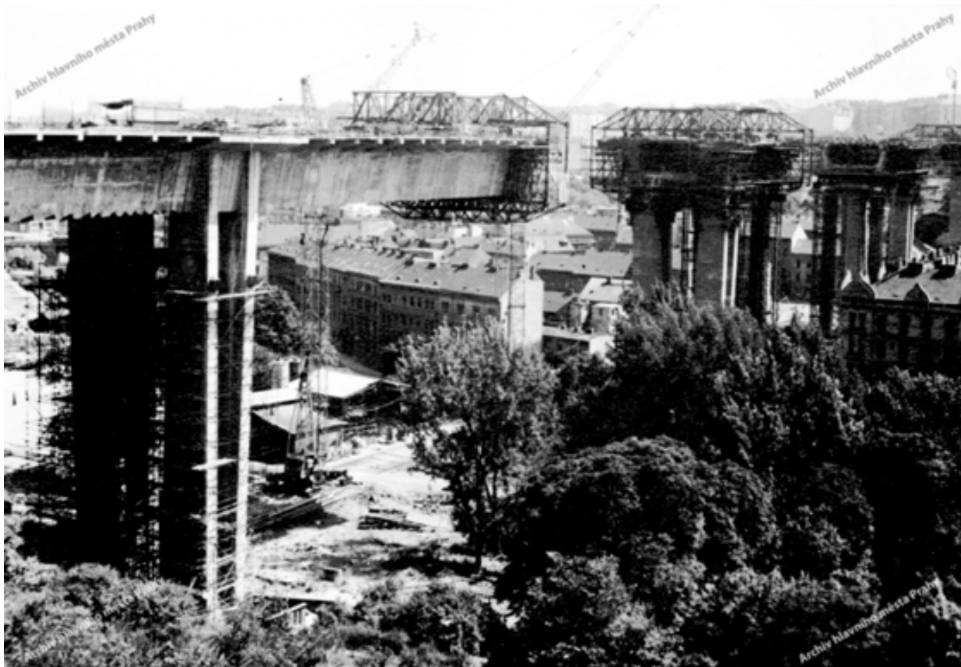
Pohled na stavbu Nuselského mostu. Foto Rudolf Jelínek, kol. 1970.
