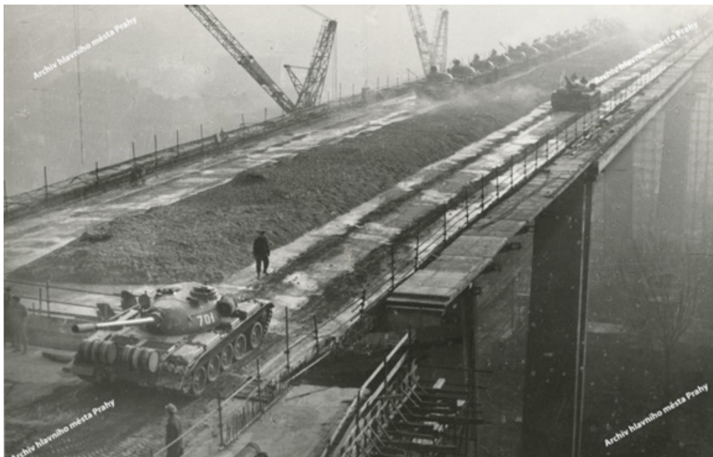
Stavba Nuselského mostu. Zatěžkávací zkouška 66 těžkými tanky. Foto Josef Vopravil, listopad 1970.
