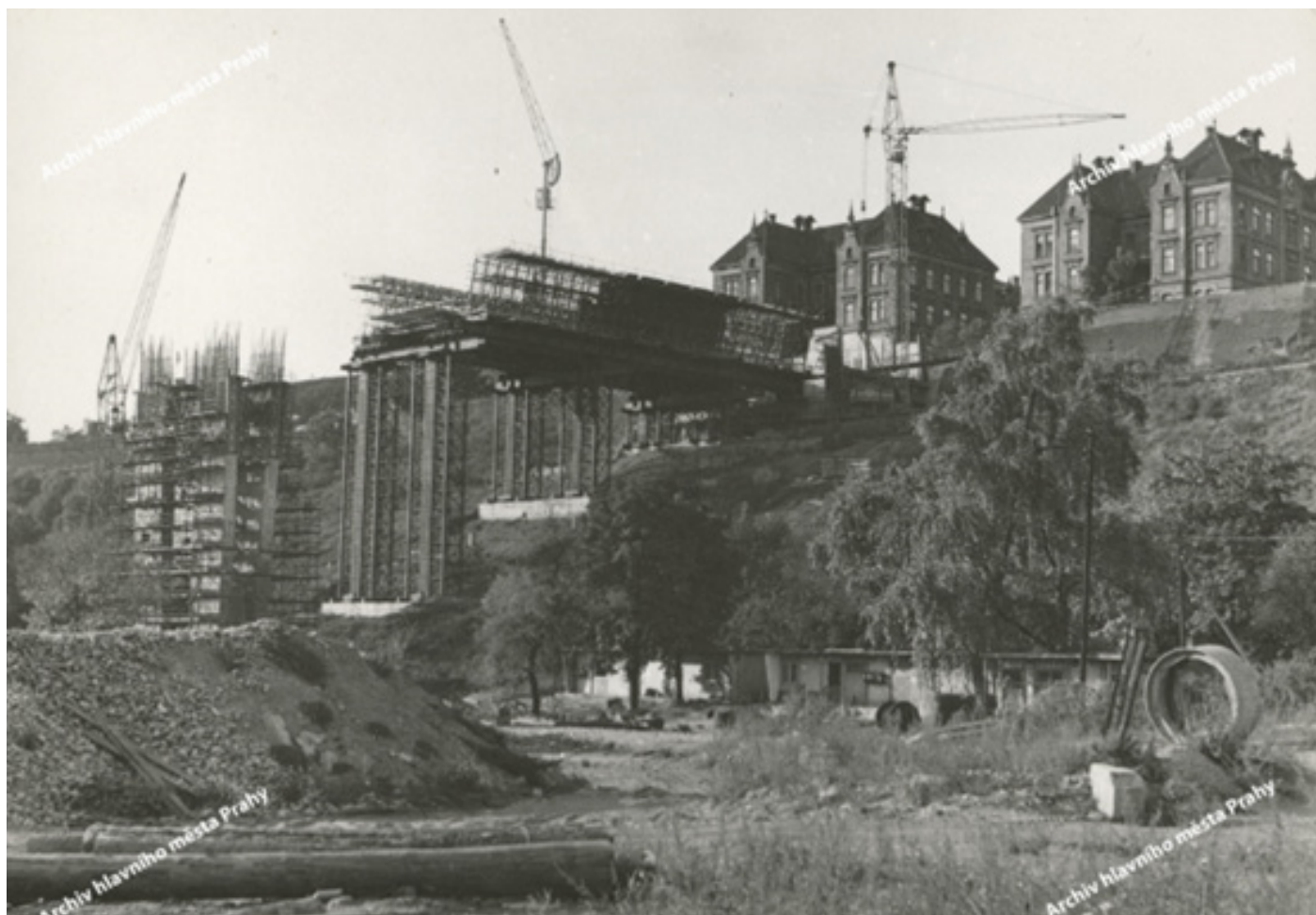
Počátky stavby Nuselského mostu na novoměstské straně. V pozadí dům čp. 1962 (Česká dětská nemocnice) na Novém Městě. Foto Rudolf Jelínek, kol. 1968.
