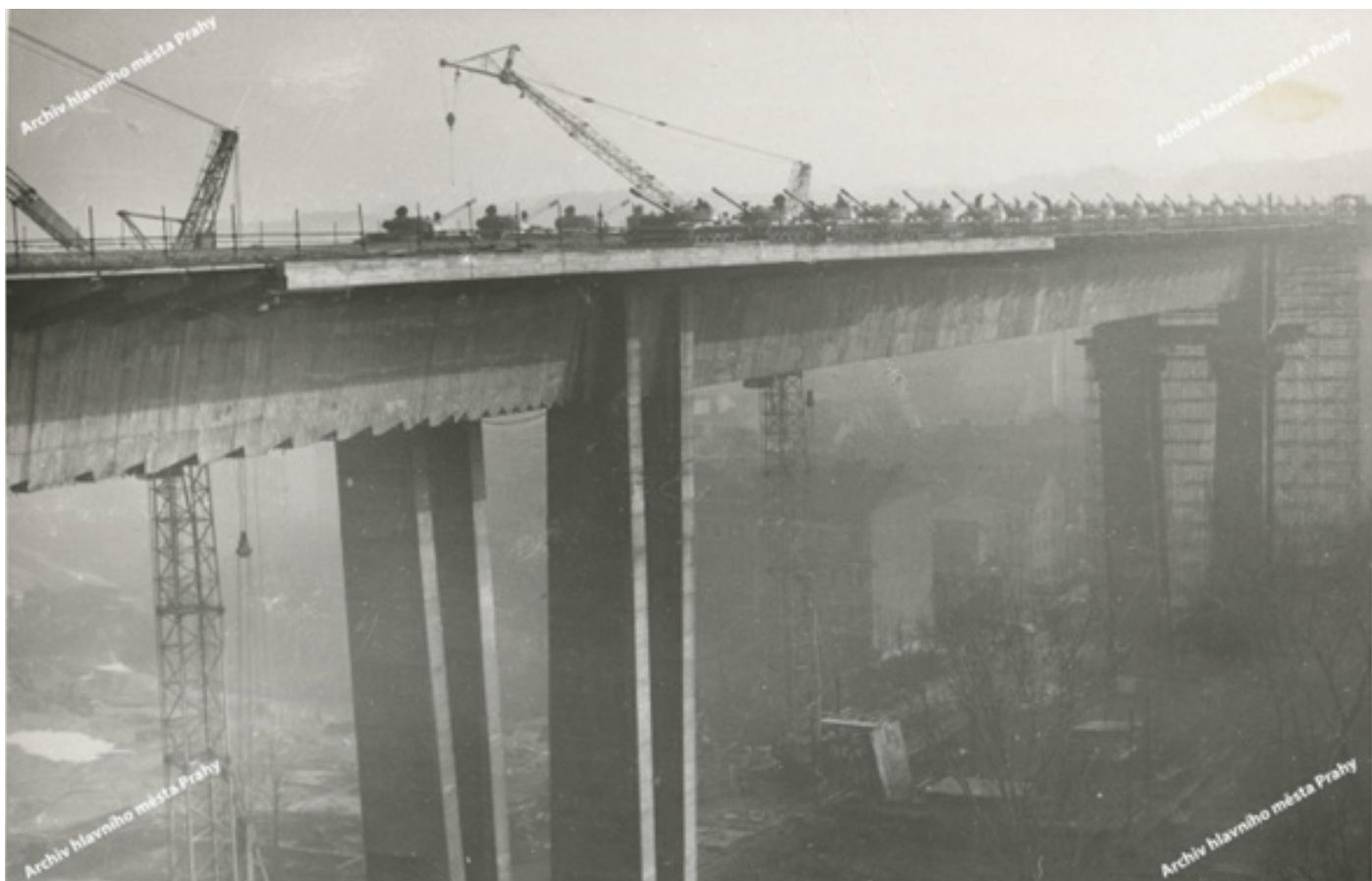
Stavba Nuselského mostu. Zatěžkávací zkouška těžkými tanky, v pozadí nuselské údolí. Foto Josef Vopravil, listopad 1970.
