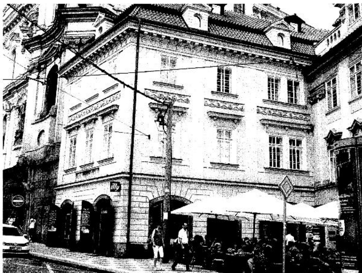
jižní část objektu
