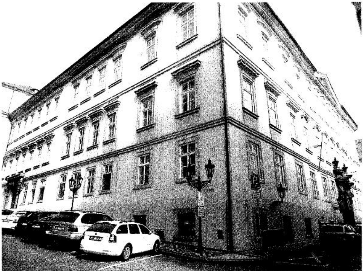
východní část objektu – č.or.17
